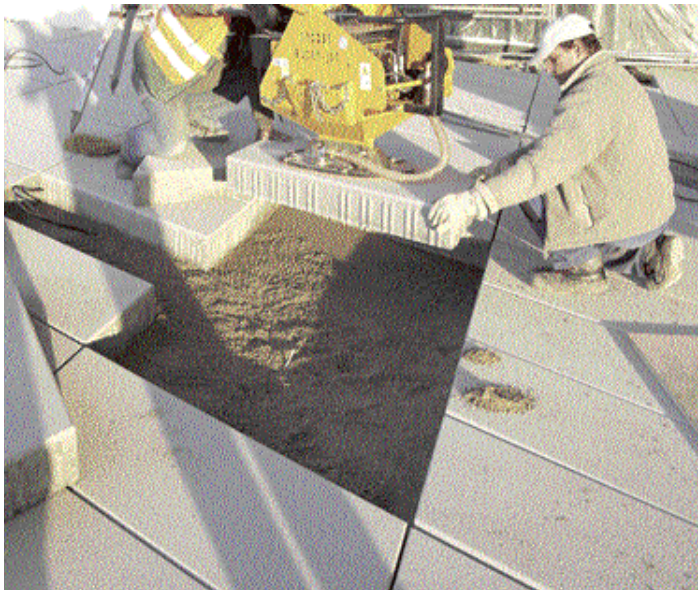
Rückenschonende Verlegearbeit, einfache Bedienung und eine enorme Arbeitserleichterung. Das Vakuum-Hebegerät SH 2500 uni b von Probst macht die tägliche Arbeit effizienter und einfacher. (Fotos: Probst)
