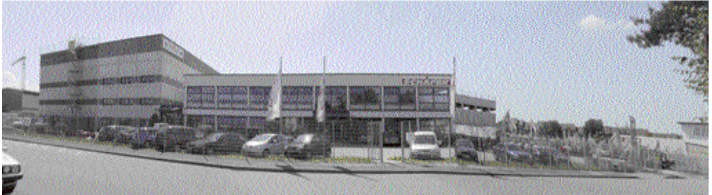
Das linke Gebäude (Hochregallager) wurde komplett neu gebaut. Somit stehen jetzt 3.100 Palettenplätze für Ersatzteile zur Verfügung. Am anderen Gebäude ist rechts ein Teil der Werkstatteverweiterung sichtbar. Auch die weiteren Optimierungen auf dem Firmengelände der Schäfer GmbH in Mannheim stellen die Weichen in Richtung Zukunft (Foto: Schäfer GmbH)
