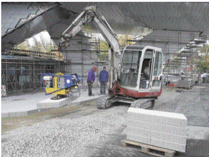
Das Vakuum-Hebegerät SH 1000 SUPER-JET h überzeugt durch seine einfache Handhabung. Dank des hydraulischen Drehmotors können die schweren Betonplatten mühelos angehoben und millimetergenau verlegt werden.
