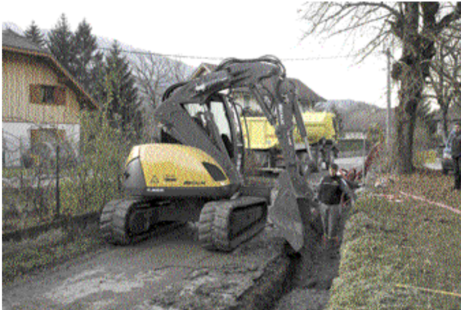
Mecalac 8MCR (Foto: Ahlmann Baumaschinen GmbH)
