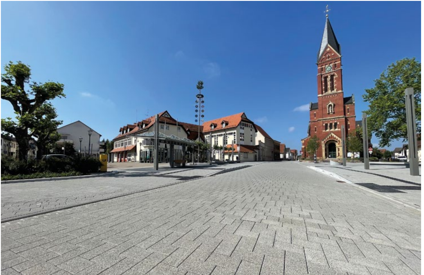
Pflastersystem COMBICONNECT aus dem Hause Beton Pfenning wird die Fuge aus EPDM gebildet. (Foto: Beton-Pfenning)
