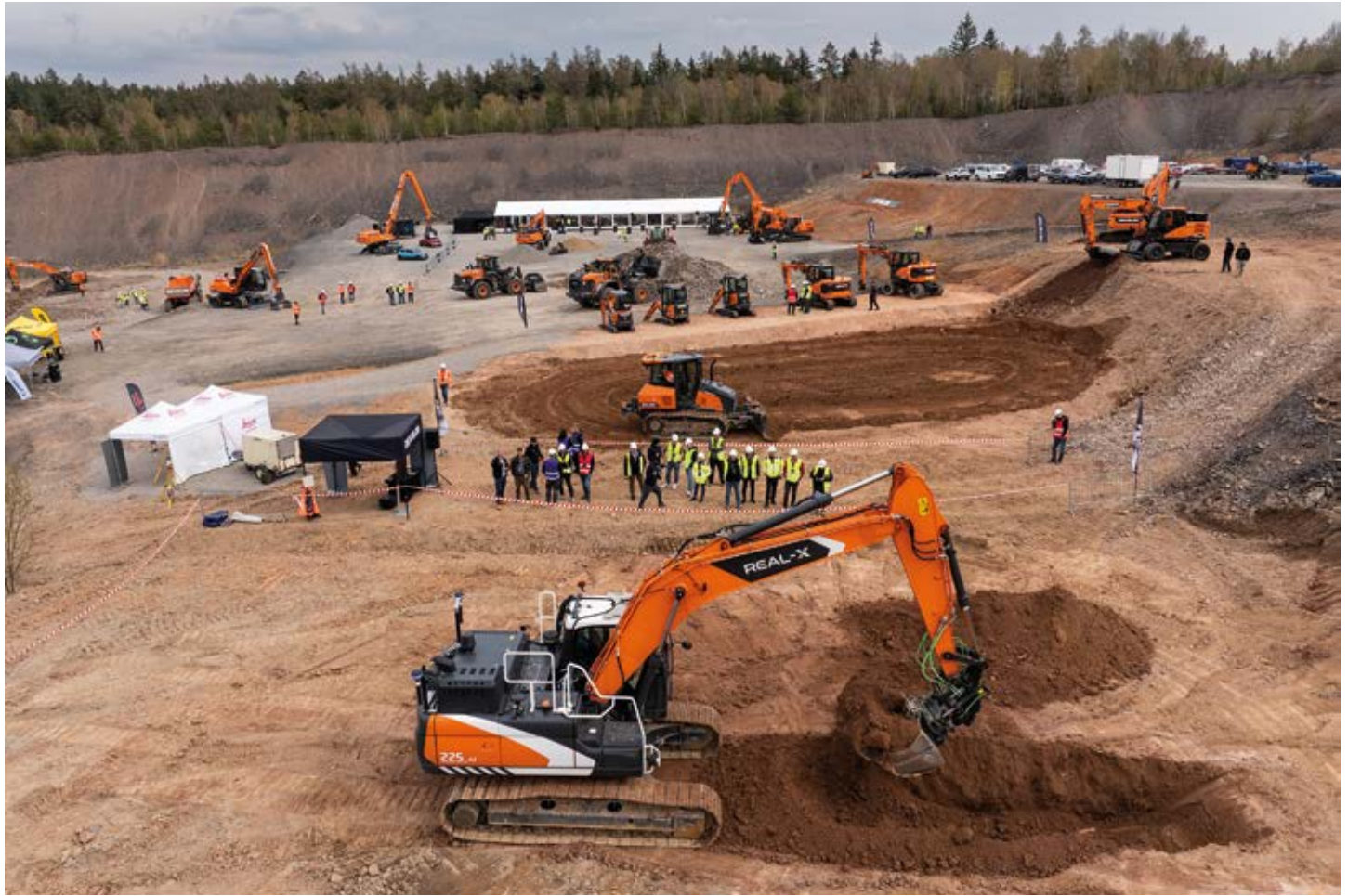
Viel Applaus: Die Live-Demonstration des Real-X-Systems zogen viel Aufmerksamkeit auf sich, zeigten sie doch, wie präzise KI-gestützte, autonome Aushubtechnologie arbeitet. (Fotos: DEVELON)
