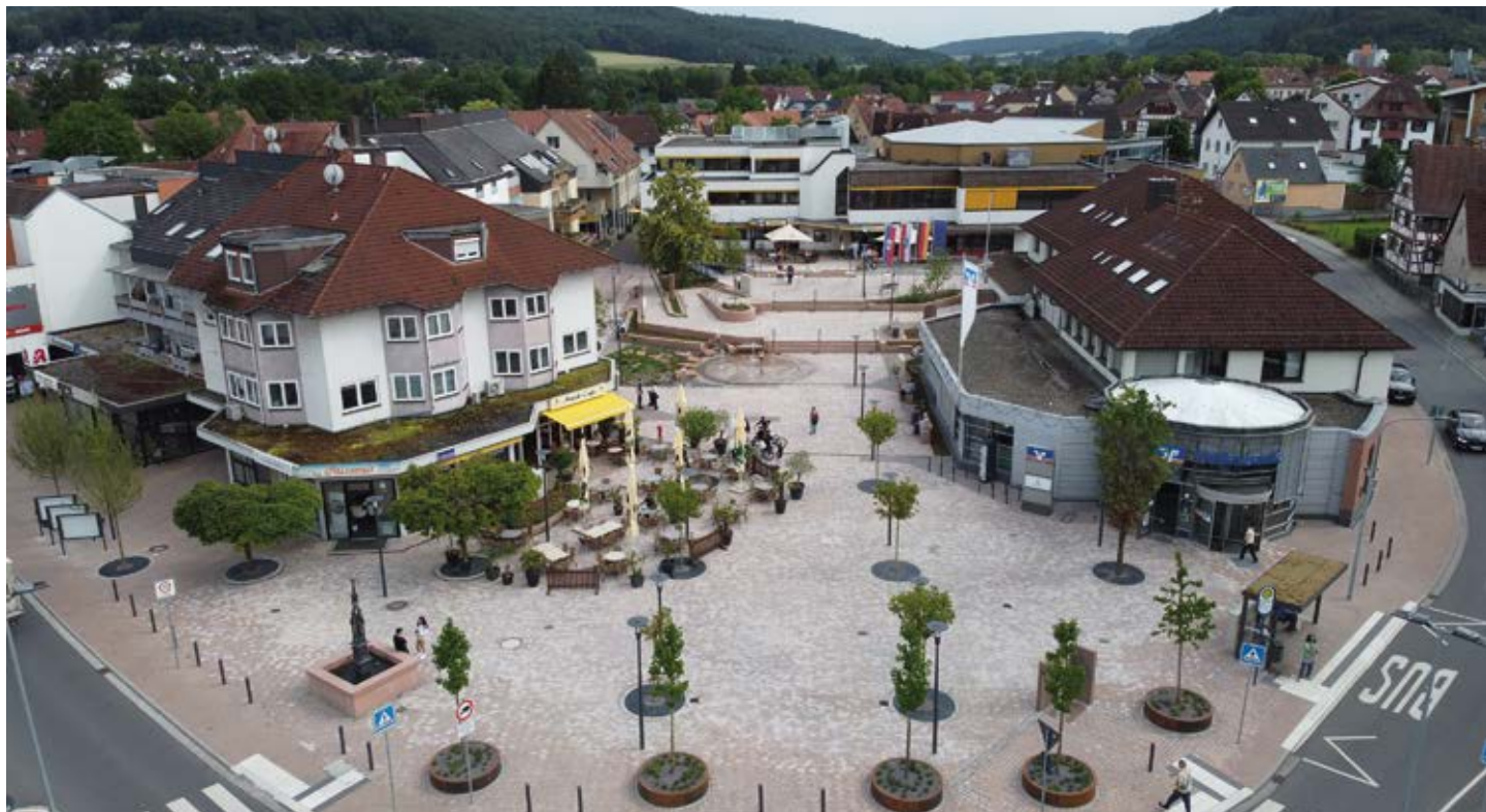
Die sanierten Flächen des Montmelianer Platzes in Höchst im Odenwald fungieren als Bindeglied zwischen dem Rathaus, den angrenzenden Häusern und dem zentralen Verkehrsknotenpunkt. (Fotos: Beton-Pfenning)
